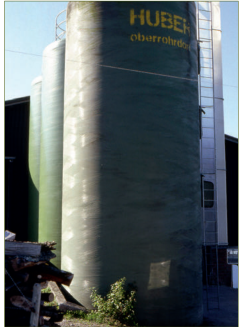
Heute werden Hochsilos aus GFK-Kunststoff, Stahl und vereinzelt noch aus Beton oder Holz gebaut.
