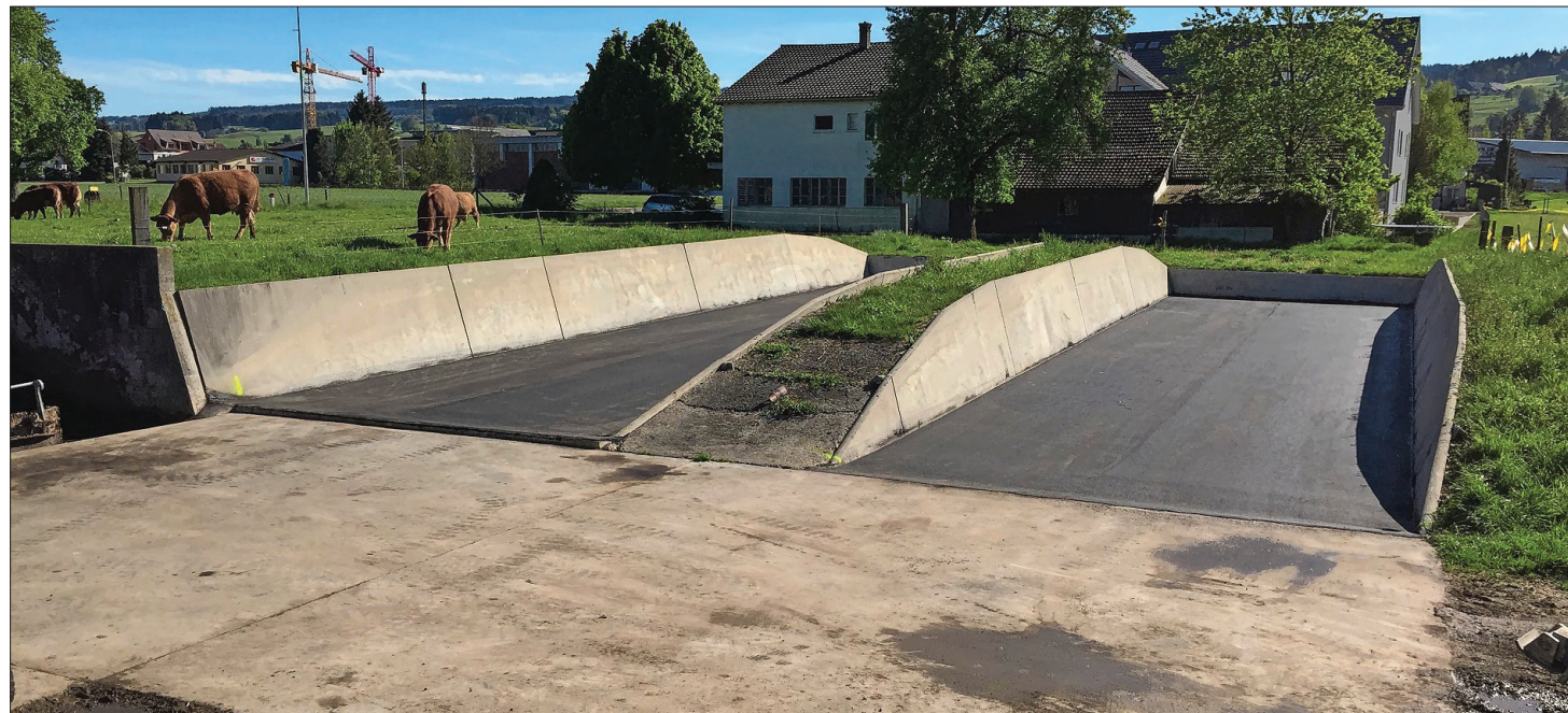
Asphaltböden haben besonders positive Eigenschaften gegenüber den Gärstoffen aus dem Futter. (Bild: zvg)
