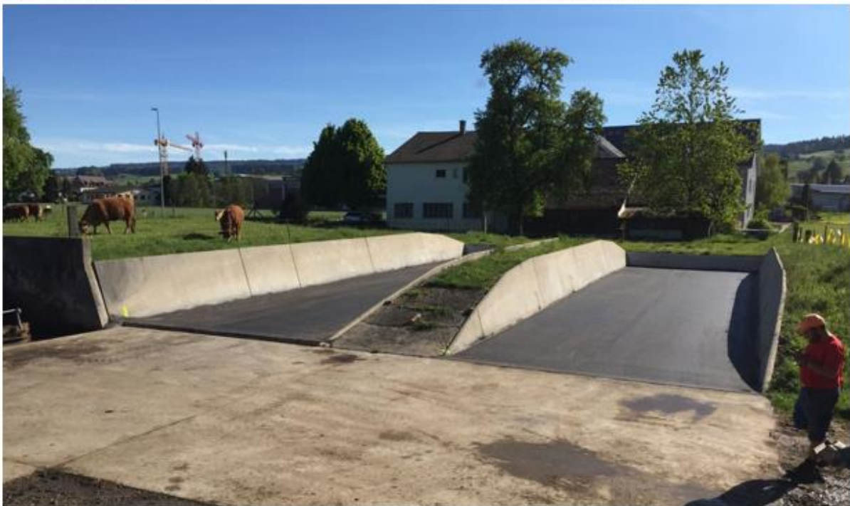
Haftbrücke wird aufgebracht
