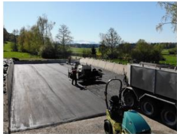
Fahrsilosanierung mit Asphalt
